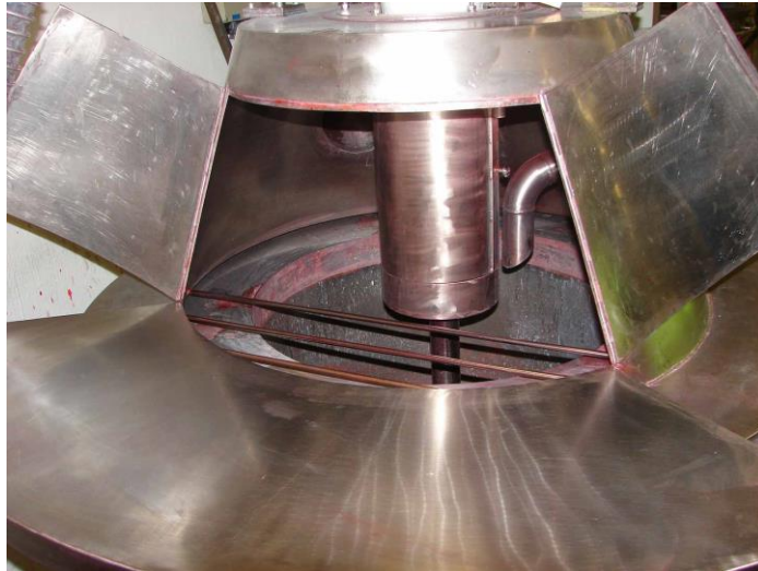
Bild 4: Durch Schutzrohr schwer erreichbare Welle
